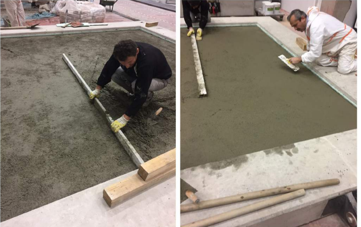
6 cm kalınlığında şap atılması
